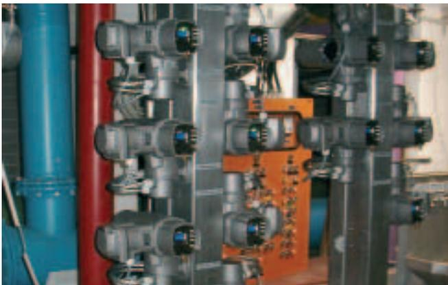
AUMATIC "Sammelstelle" in einem Wasserwerk. Die Steuerungen sind getrennt von den zugehörigen Antrieben auf Wandhaltern montiert.
