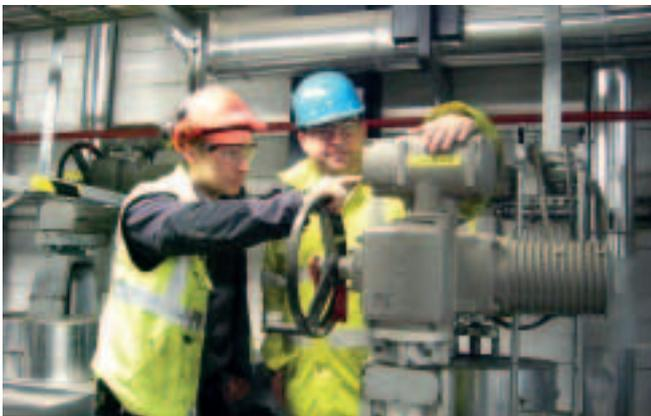
Drehantrieb SA mit AUMATIC auf einem Schieber in einem Torfkraftwerk in Irland.
