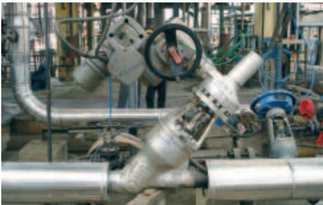
Feuerfeste Ausführung eines AUMA Drehantriebs SA mit AUMATIC – Geräte mit dieser Ummantelung bleiben im Brandfall bei Temperaturen bis 1 100 °C min. 30 min funktionsfähig.
