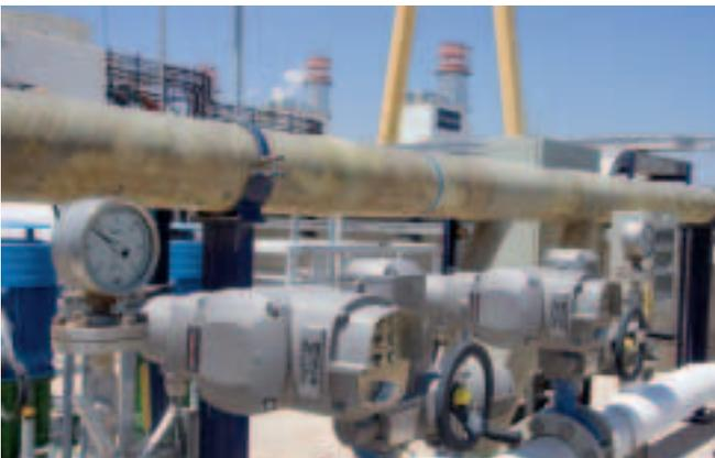
Schwenkantriebe SG mit AUMA MATIC in einem Kombikraftwerk in Spanien.
