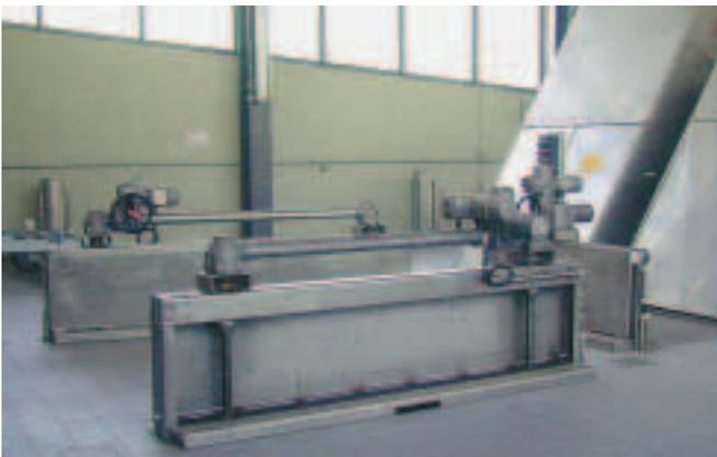
Mehrere Doppelspindelschieber in einer Kläranlage. Die Kombinationen aus Drehantrieben SA und Drehgetrieben GK werden je mit einer AUMA MATIC gesteuert.
