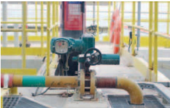
Extreme Bedingungen: Hitze kombiniert mit salzhaltiger Meeresluft. Schwenkantrieb SG mit AUMA MATIC in einer Industrieanlage in Katar.
