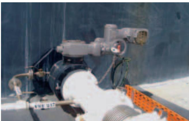
Explosionsschutzgehäuse Drehantriebs-/Schwenkgetriebe Kombination SAExC/GS mit AUMA MATIC auf einer Klappe in einem Tanklager auf den Azoren.
