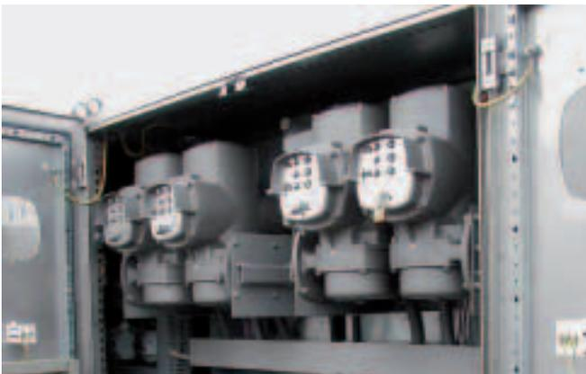
Auch das geht, zentrale Unterbringungen mehrerer AUMA MATIC in einem Schaltschrank mit Hilfe der Wandhalterlösung.
