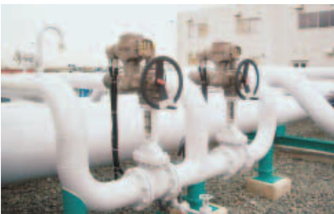
Drehantriebe SAExC mit Steuerung AMExC im Kerosinverteilungssystem des Flughafens Chubu in Japan.
