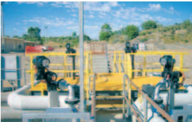
Drehantriebs-/Schneckengetriebe Kombination in einer Wasseraufbereitungsanlage in Australien.
