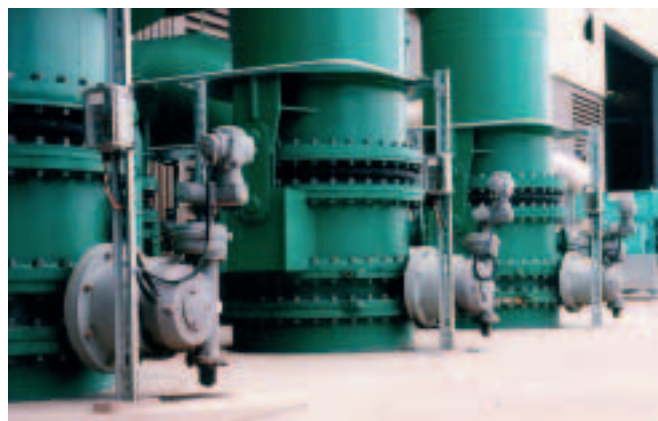
GS 500 Getriebe mit Vorgelege und angebauten Drehantrieben SA in der Rauchgasentschwefelungsanlage eines australischen Kraftwerks.
